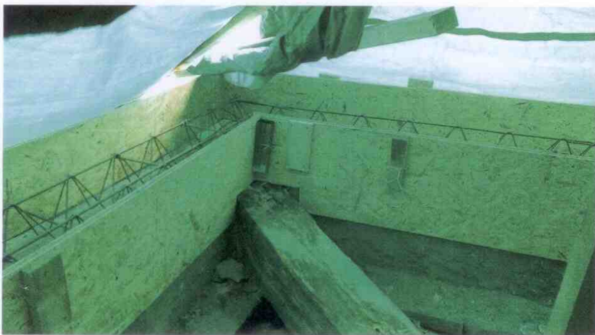
Detail šalování pro železobetonový věnec
