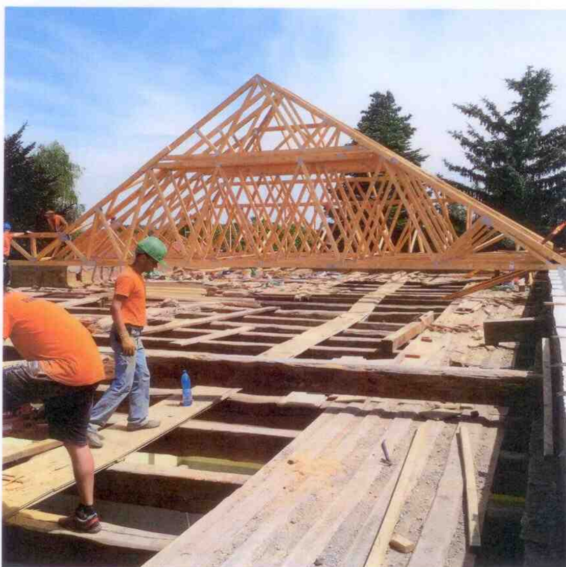
Průběh montáže vazníků
