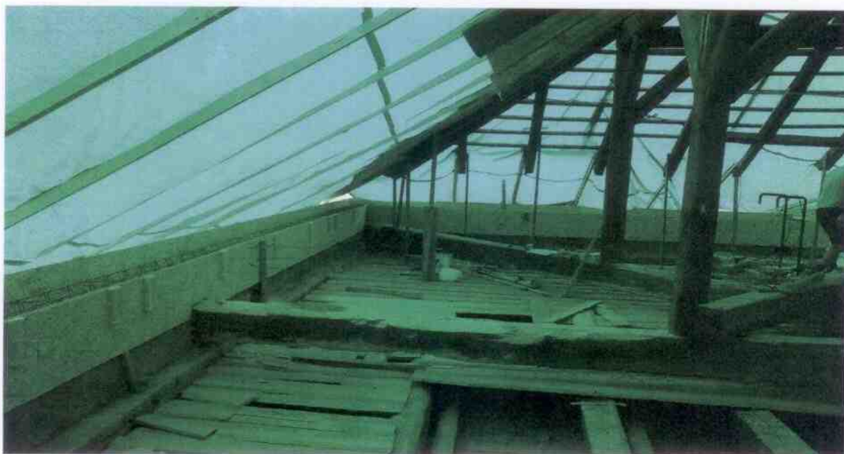
Průběh demontáže vrchní části podlahy půdy
