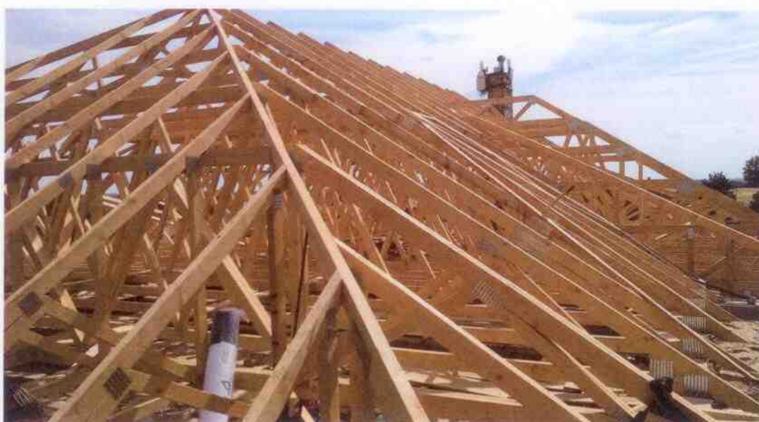
Vazníková konstrukce je připravena pro montáž střešní folie
