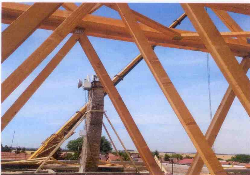
Manipulaci vazníků ze země nahoru zajišťoval jeřáb Hanyš 90
