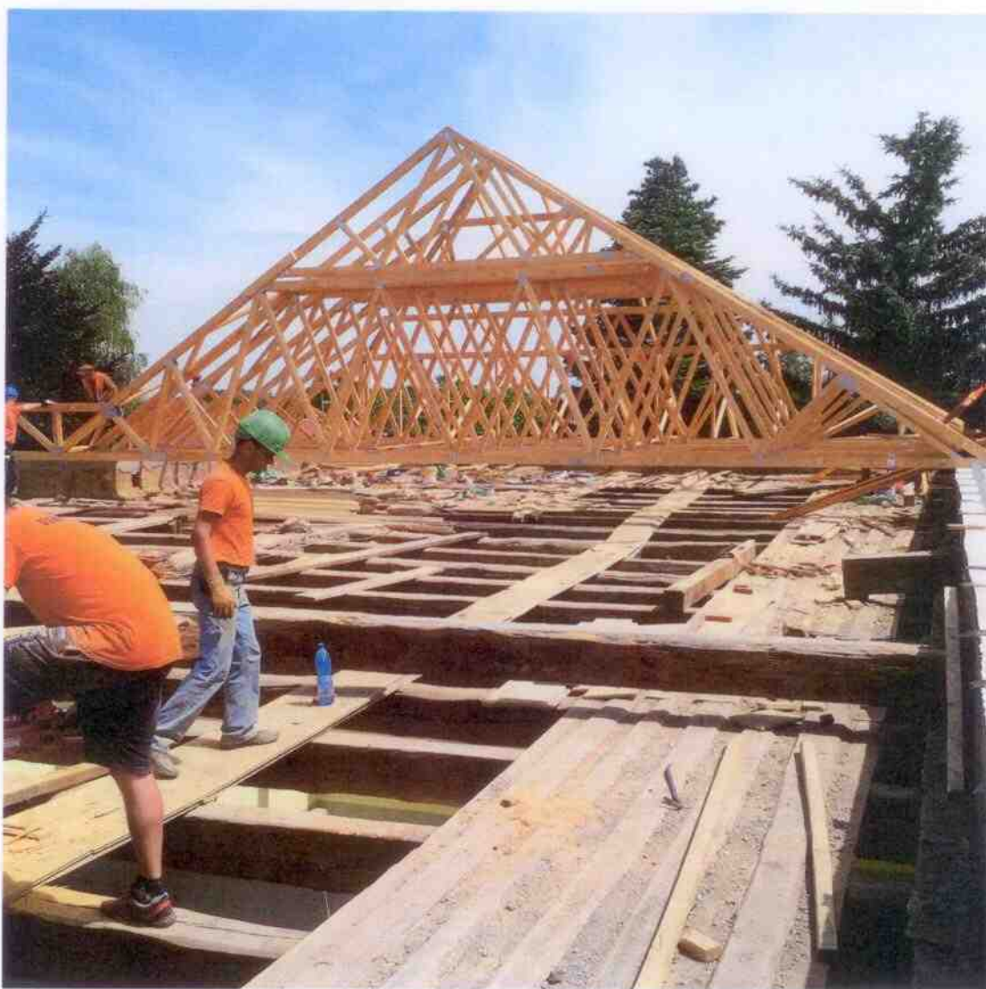
Průběh montáže vazníků
