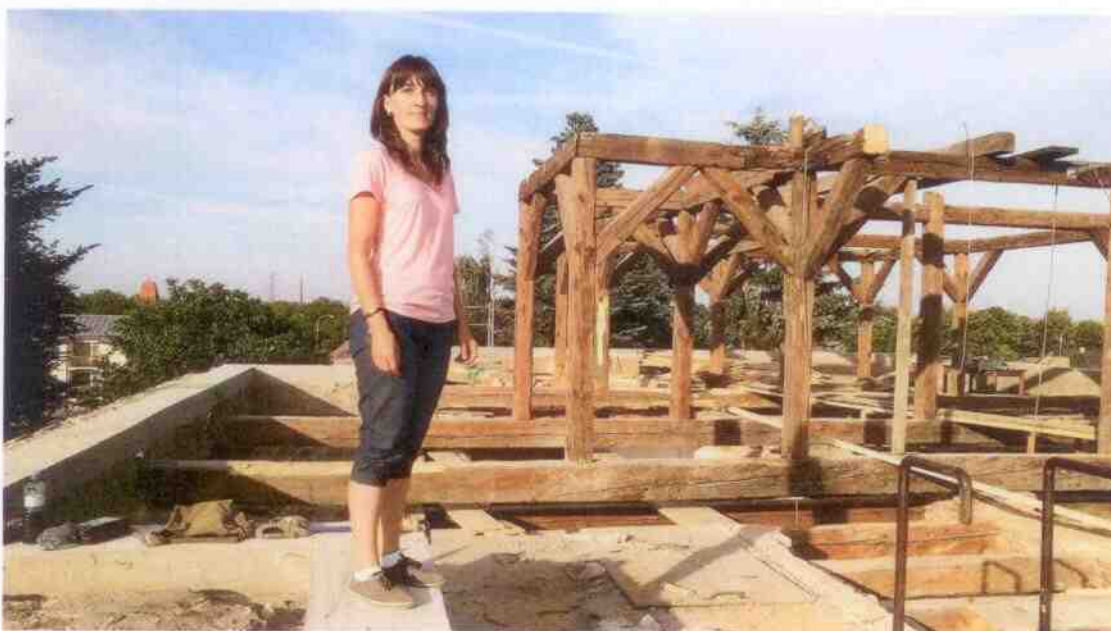
Kontrola staveniště v rámci demontáže krovu
