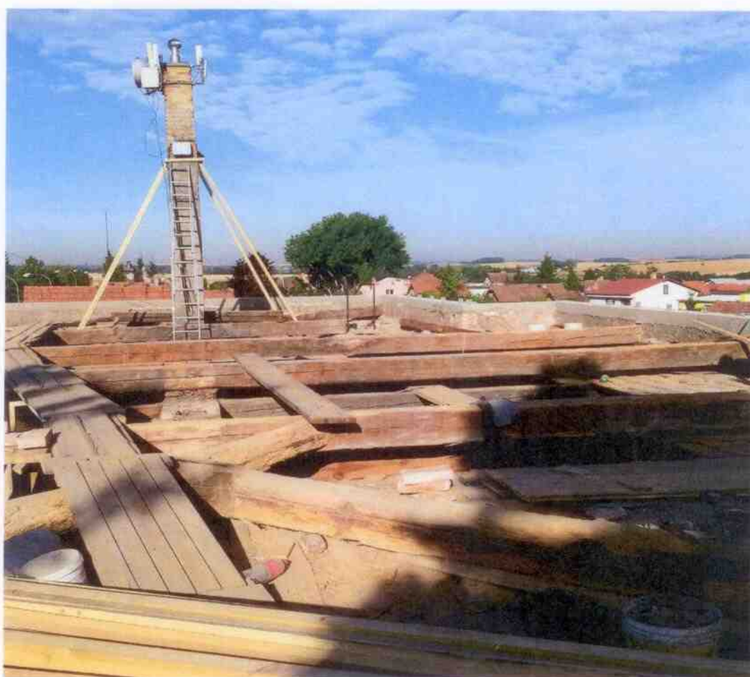
Demontáž krovu dokončena
