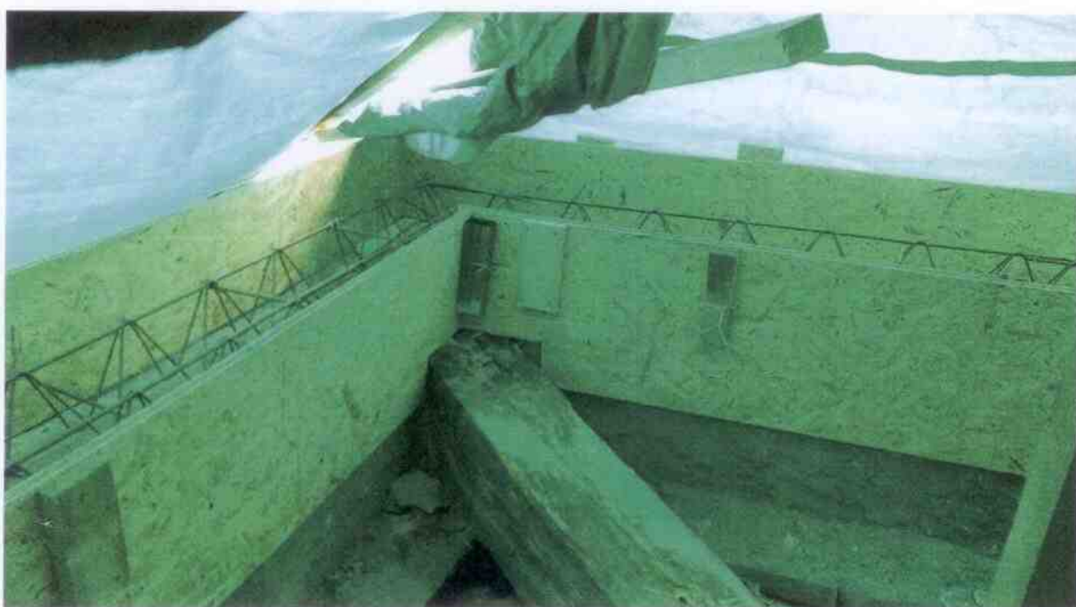
Detail šalování pro železobetonový věnec
