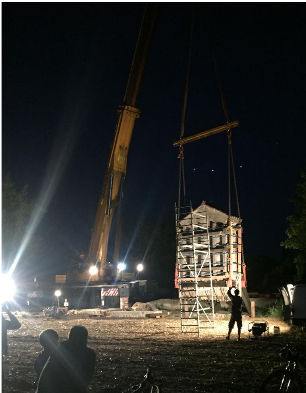
Přemístění Strašenské kapličky jeřábem
